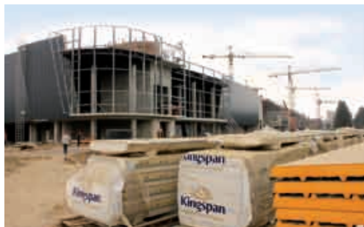
ТРЦ «Республика» возле Одесской площади в Киеве. В процессе строительства будет смонтировано более 40 000 м² сэндвич-панелей Kingspan, в том числе по радиусу
